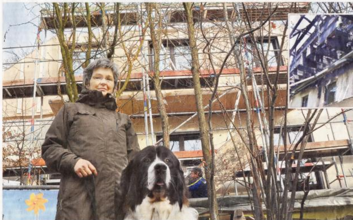
Die Friedewalderin Angela Franke, auf dem Foto mit ihrem Lebensretter Aaron, kann sich freuen. In den vergangenen Tagen wurde der Rohbau ihres neuen Hauses errichtet. Heute feiern sie und ihr Mann mit den Helfern Richtfest. In der Nacht zum 30. Mai 2011 war der Vorgängerbau durch ein Feuer zerstört worden (kl. Foto). Foto: SZ/S. Görner
